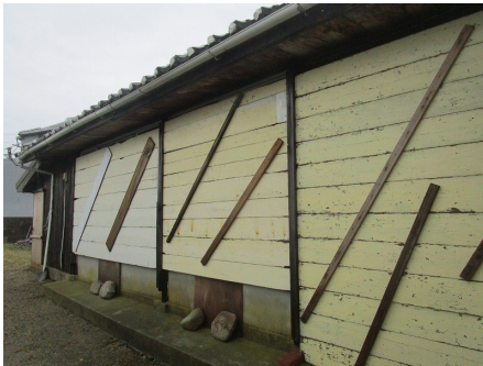
差し板の上に補強の板を打ちつけて、しっかり台風対策
