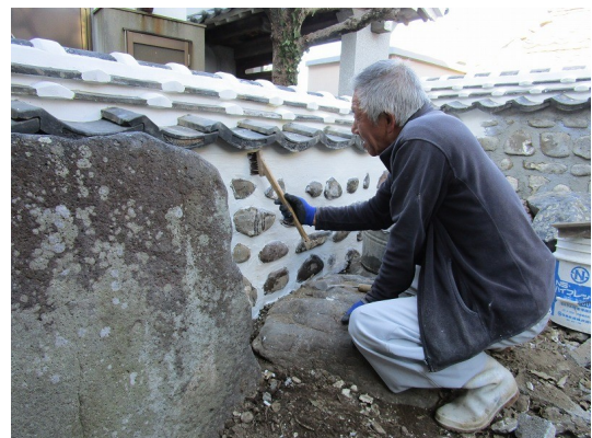
土が落ちている箇所はモルタルで埋めて漆喰で石の間をきれいに塗り、最後にハケで仕上げ
