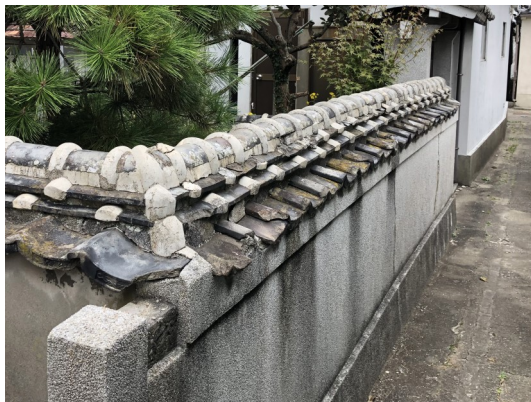
塀の瓦が欠けたり漆喰が取れたりしていたので修理をお願いすることに
