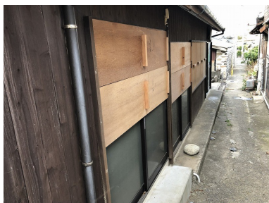
戸板を立てて台風にも備える
