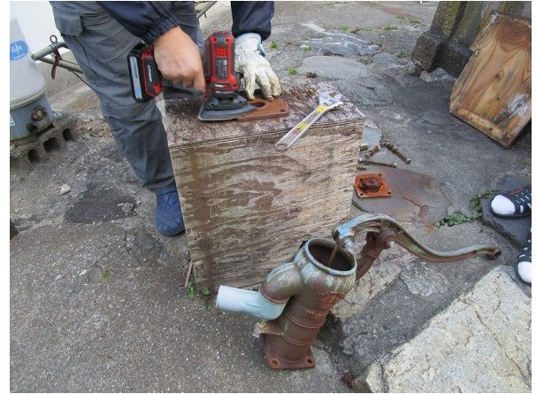
手押しポンプの部品交換作業
